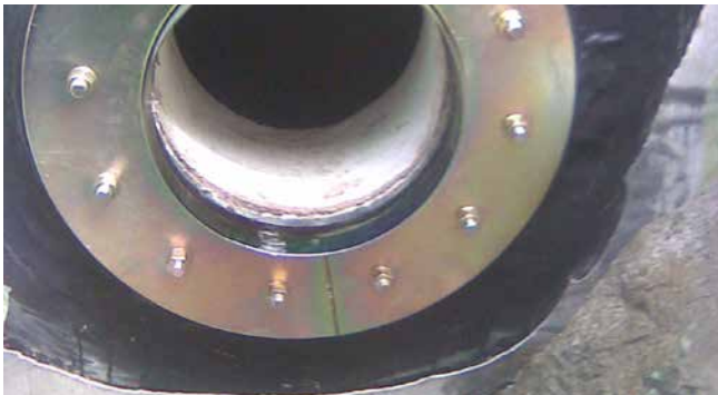
FLFA 400 A3C Entwässerungsanbindung
