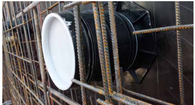
UFR in Schalung
