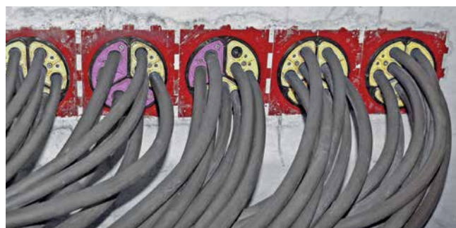
Kabelzug durch HSI-Dichtpackungen mit SEGMENTO-Systemeinsätzen
