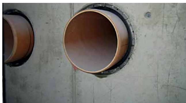
HSD500 G 1x429 b40 A2/EPDM55 Be-/Entlüftung
