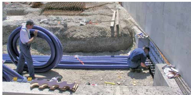
Verlegung Kabeleinführungssystem KES-M 150 mit Manschettentechnik
