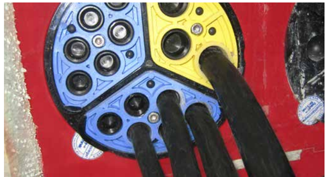
HSI150 SEGMENTO mit integrierter Drehmomentkontrolle und Blindstopfen
