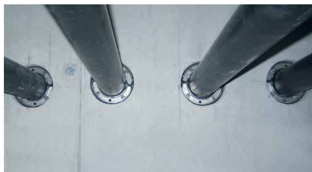
HSD125 1x75 b20 A2/EPDM55 Leerrohranbindung
