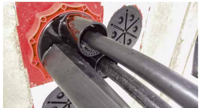
Zentrierband im Systemdeckelstutzen des HSI150 D3x58 WS
