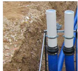
Reihenanzordnung 2x KES90 MA ZVR100/500 an der Aufstellvorrichtung KES FUBO-FIX AV
