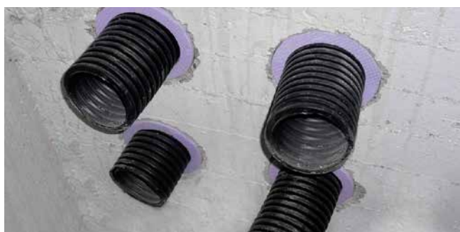
Ansicht Gebäudeinnenseite (Isoring)
