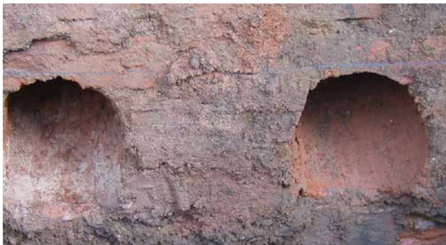
Schräge Kernbohrung in porösem Mauerwerk
