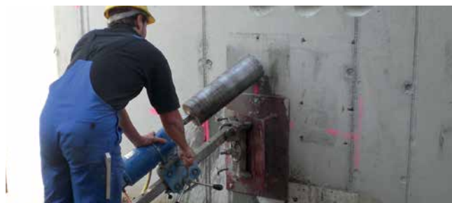
Herstellen von vertikal und horizontal verlaufenden Diamantschrägborkern für die Aufnahme von HRD-Dichteinsätzen
