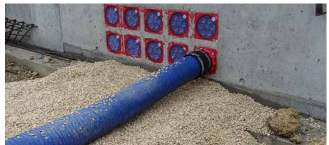
Anschluss des Kabeleinführungssystems KES MA150 D
