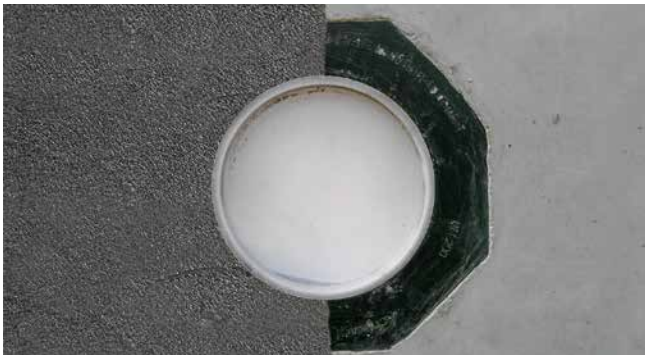
Betoniertes UFR mit PMBC
