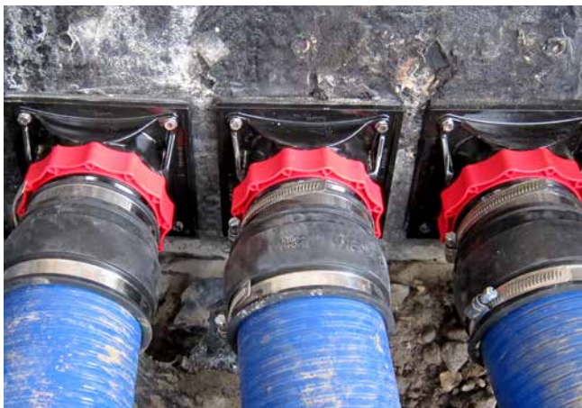
HSI90 DF mit angeschlossenem Systemdeckel HSI90 MA110 WR
