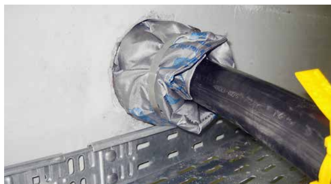
HSS – Einbau in Kernbohrung mit HRD Ringraumdichtungen
