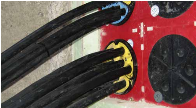
Abdichtung von Kabeln für Straßenbeleuchtung mit SEGMENTO
