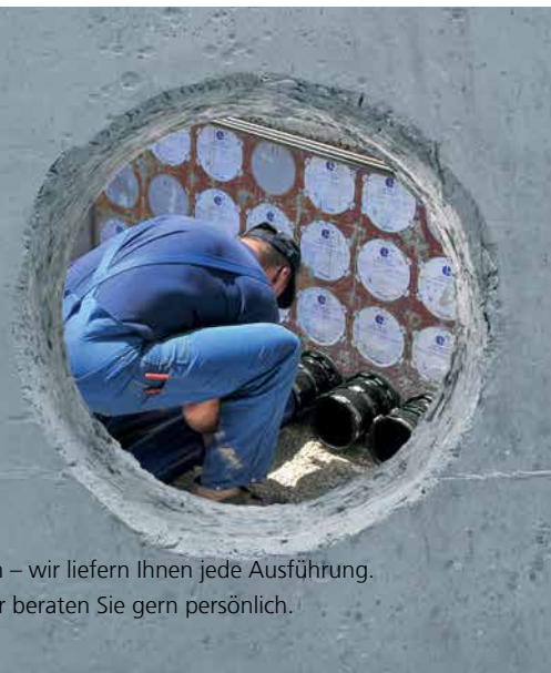
Herstellen von vertikal und horizontal verlaufenden Diamantschrägborkern für die Aufnahme von HRD-Dichteinsätzen
