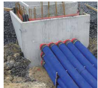
KES MA90 D – Anschluss an Dichtpackung HSI90
