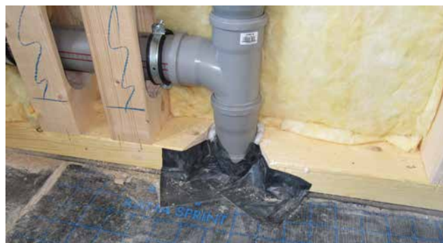
Schwierigkeit: Einbindung der Dampfsperre
