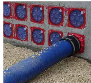
Druckdichter Anschluss an die HSI150-Dichtpackungen
