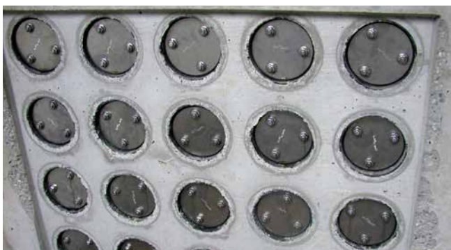
FZR100/240 Abdichtung Rohrtrasse
