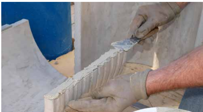
FZRG350/300 mit Spachtelmasse aus Montageset Z-FZR-G
