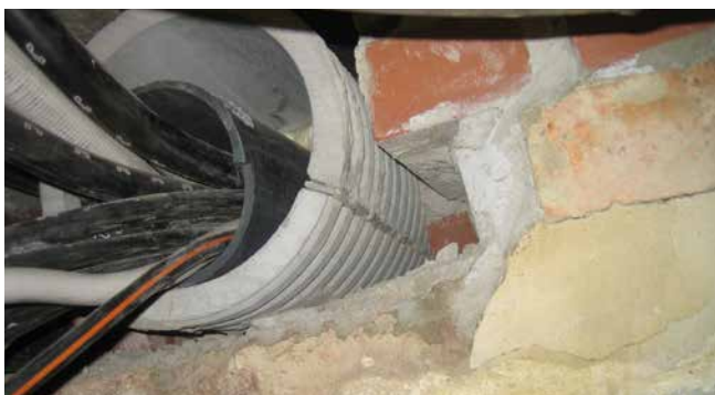
FZR100 / 240 Abdichtung Rohrtrasse
