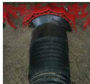
Wellrohranschluss mit Kaltschrumpftechnik HSI150 D1x110 KS WR
