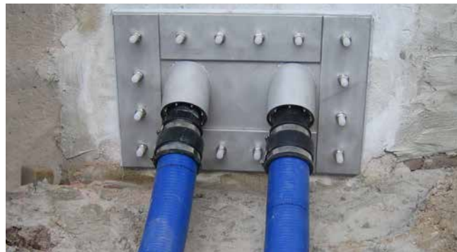
Fest-/Losflansch mit schräger Leerrohranbindung vor Flächenabdichtung
